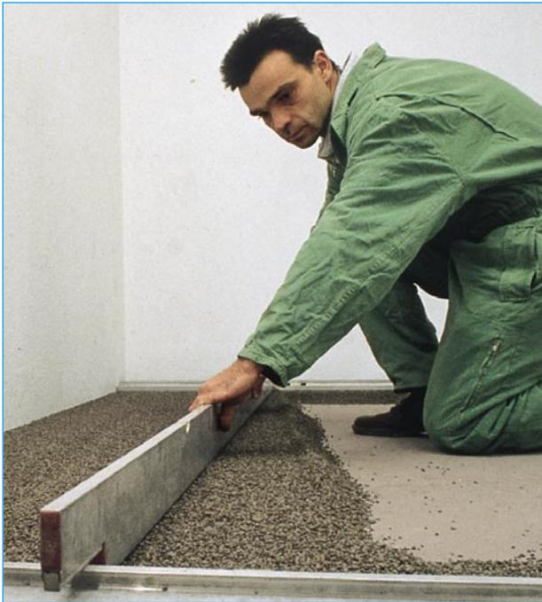
Die nichtbrennbare Trockenschüttung Siliperl® zeichnet sich durch hohe Kornfestigkeit und hervorragende Dämmeigenschaften aus und ist einfach zu verarbeiten. Das vielseitig nutzbare Granulat ist sicher vor Verrottung und chemisch neutral. Es verzahnt sich zu einer nachverdichtungsfreien, stabilen und tragfähigen Ausgleichsschicht.
